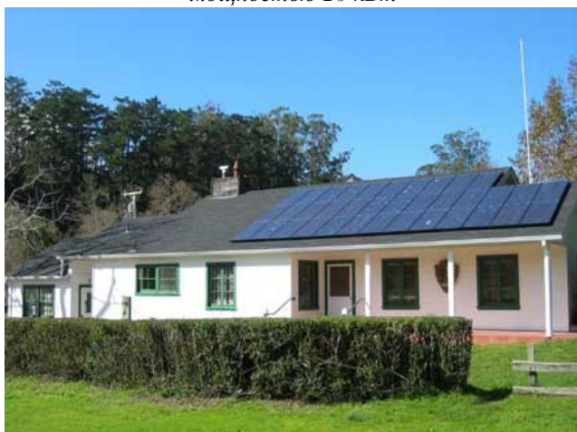
Рис. 3. Дом лесника со встроенными на крыше фотоэлектрическими модулями (США)
